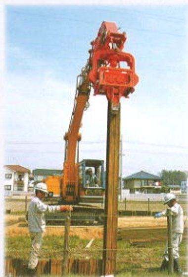
HP-4SX (道路開設工事)
