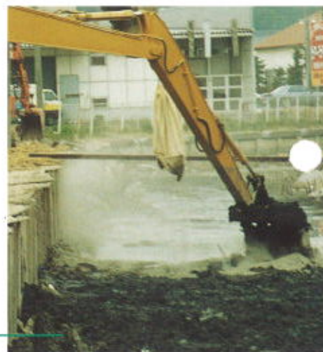
ミキシングフォーク 作業現場
