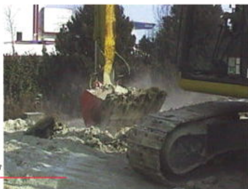
ドライブミキシング 作業現場
